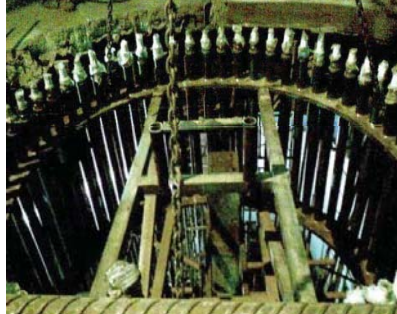
ก่อสร้าง ฐานรากรับ Turret ข้างเตาหลอม - N.T.S.Steel (2552)
