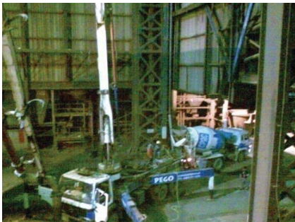
ก่อสร้าง ฐานรากรับ Turret ข้างเตาหลอม - N.T.S.Steel (2552)
